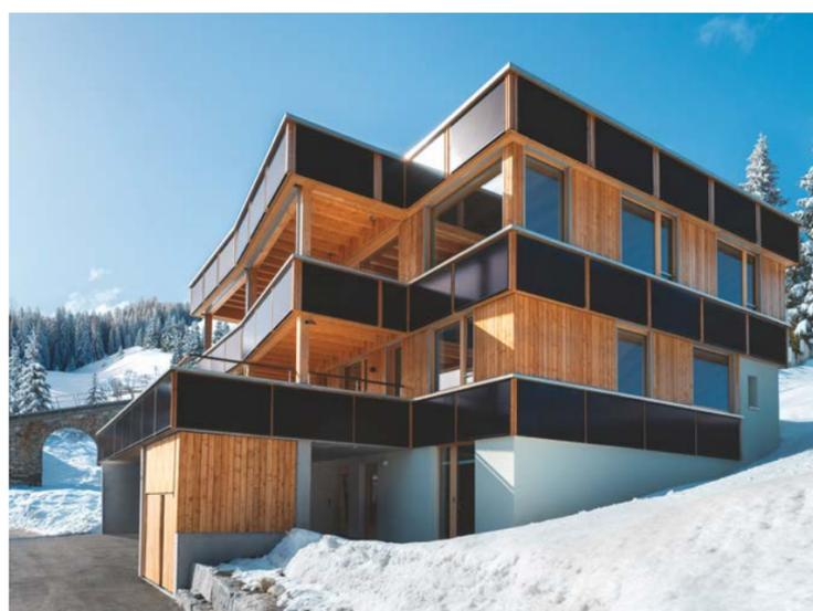
Bilder oben und ganz unten: Die Herausforderung lag darin, die PV-Module so in die Holzelementfassade zu integrieren, dass sie ein selbstverständlicher Teil des Hauses sind. BILDER ANGELO BRACK, DAVOS
