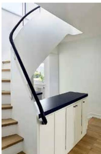
Die Handläufe an den Treppen sind aus dampfgebogenem Holz gefertigt.
