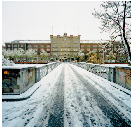
Eine Mittelachse führt durch das gesamte Kasernenareal.
