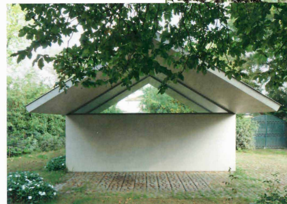
Ein Kartenhaus im Garten, im Niemandsland. Die prekären Auflager der auskragenden Dach-Scheiben sind in der abstrakten Komposition verborgen.
